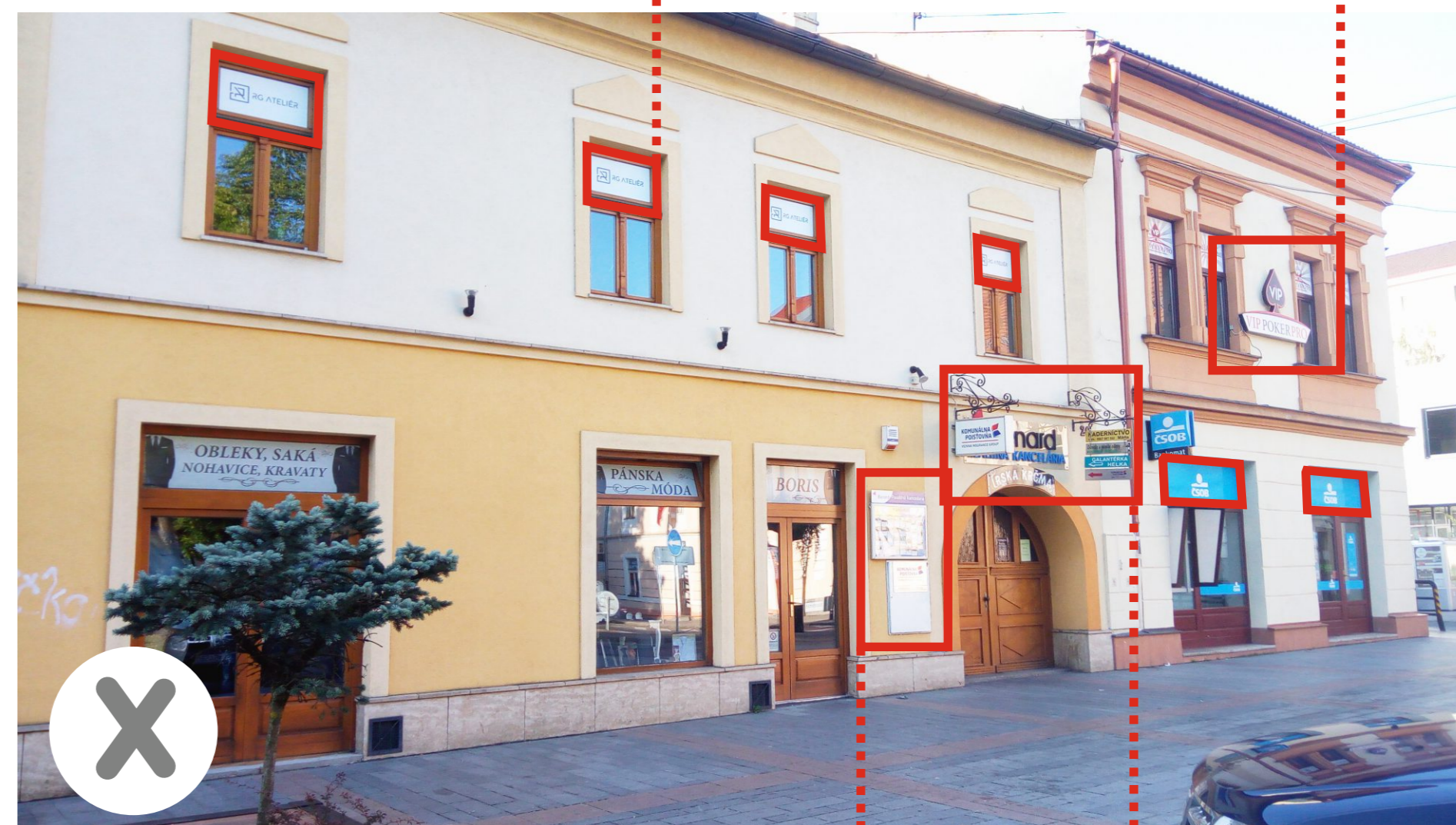
Nevhodná forma reklamy: Systém označenia viacerých prevádzok nie je jednotný Štít má nevhodnú formu
