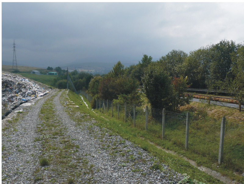
Fotodokumentácia č. 3: Kontakt III. kazety skládky s cestou č. I/68
